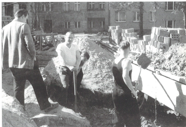
Mitglieder bei Eigenleistungen auf der Baustelle Tiroler Straße 51 - 57 im Jahre 1958
