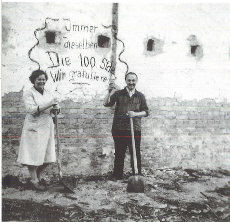
Arbeitseinsatz von Mitgliedern zur Erbringung der Eigenleistungen
