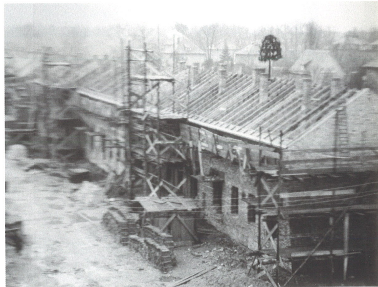
Die ersten Häuser Hermann-Hesse-Straße 5 - 7
