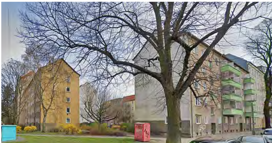
Eschengraben 36, 38 und Baumbachstraße 8, 9
