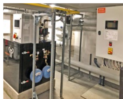
Blockheizkraftwerk
