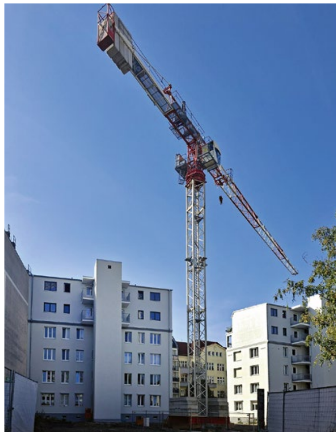
Kranaufstellung für den Neubau Hadlichstraße 21 b–k „EWG-Höfe“
