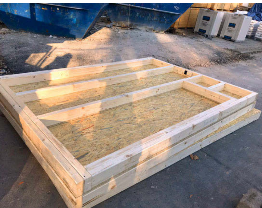
Die ersten vorgefertigten Bauelemente für die Aufstockung sind bereits vor Ort.
