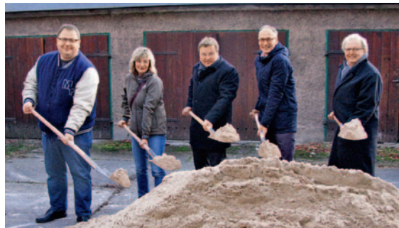
Erster Spatenstich Neubau Brennerstraße 88 A-H
