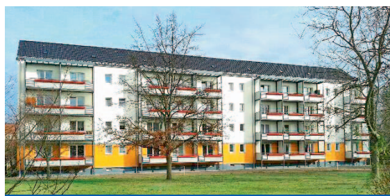
Röbbellweg nach der Modernisierung
