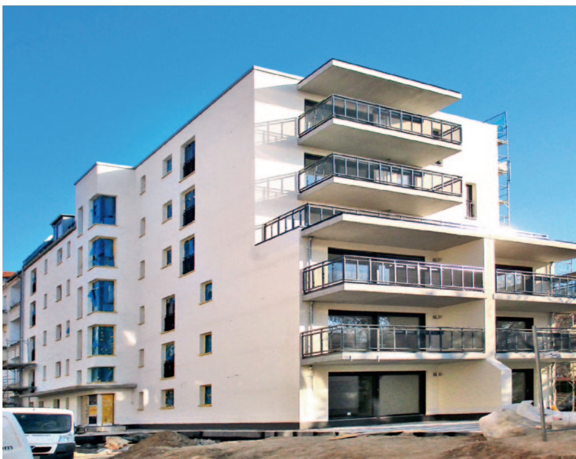
Terrassenhaus Brennerstraße 88 A – H kurz vor der Fertigstellung
