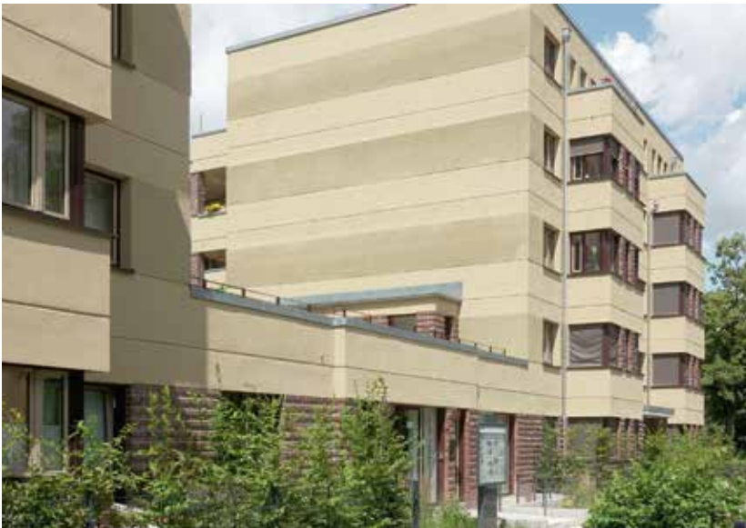
Blockrandbebauung der EWG mit 39 Wohnungen, fertiggestellt 2022. Für das Objekt wurde ein zweites Leitungsnetz installiert, das die Sammlung von Grauwasser und die Nutzung von Betriebs- und Regenwasser ermöglicht.
