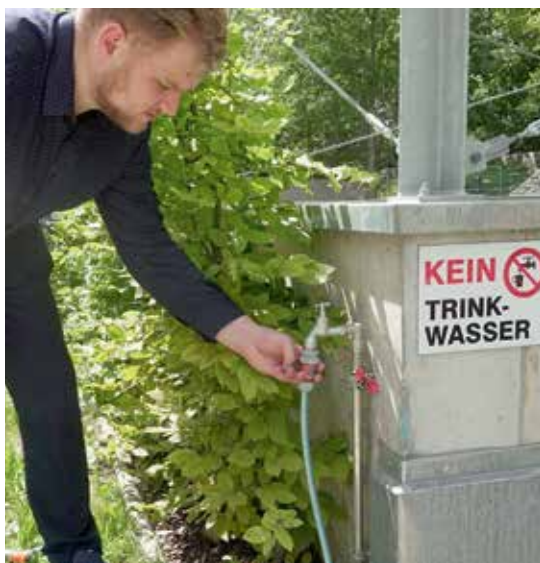
Auf den Dächern auftreffender Niederschlag wird gesammelt und zur Bewässerung des begrünten Innenhofs, der sechs Hochbeete und der Beete auf der Dachterrasse genutzt. Dies geschieht bequem mit Schlauchbrausen.
